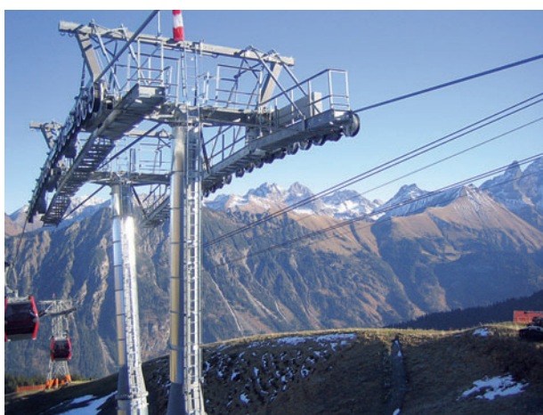
... und der Leitner-8er-Kabinenbahn am Fellhorn in Oberstdorf wurde vom TÜV SÜD vom Projektstadium an begleitet.
